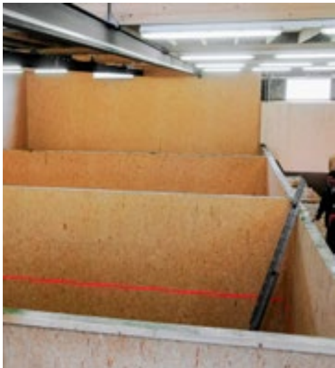
Les cellules portent un marquage bien visible pour permettre de déterminer la hauteur du tas.
