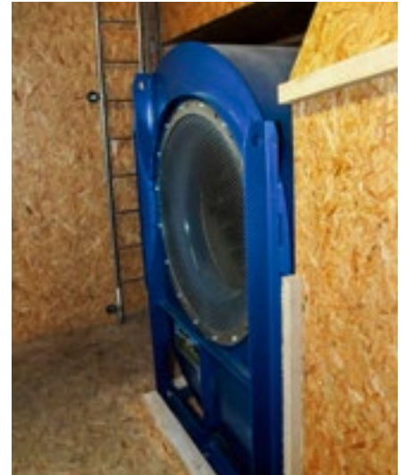
Le ventilateur spécial à pression constante demande une puissance électrique maximale de 22 kW.
